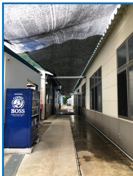
【日除けシェード設置】
